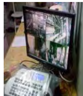
Figura 11. Sistema de circuito cerrado de TV.
