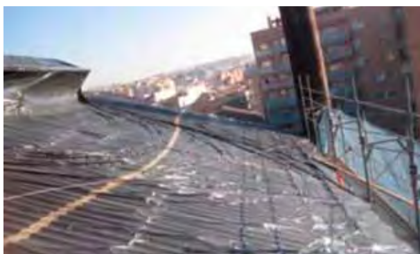
Figura 4. Trabajos previos al confinamiento
